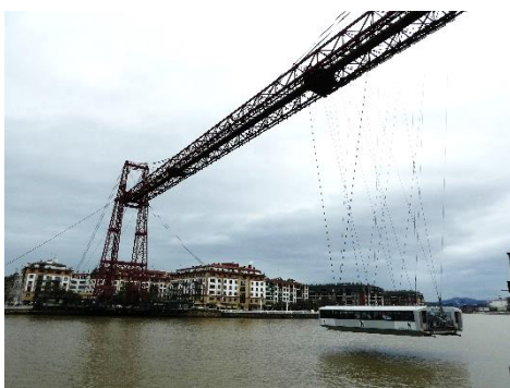
(Photo 2, le pont et sa nacelle)
