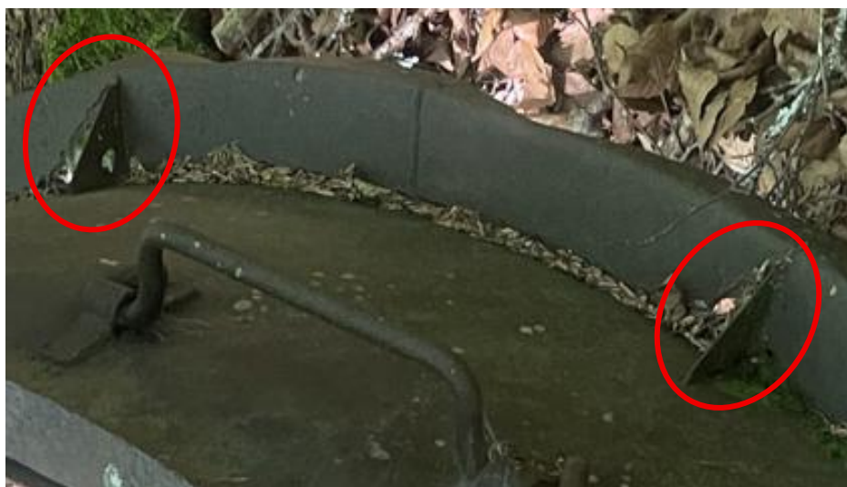
Gouttière d'interface à bords // non percés avec renforts (équerre en dessous).
