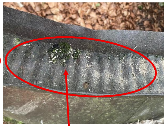
Gouttière d'interface à bords // gaufrée soudée et percée. Spécifique aux fours "La Lorraine".
