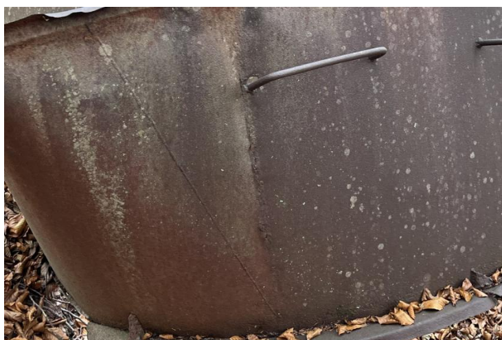
Ci-dessus, le fût riveté (double rangée), typique des "fours Tranchant ".
