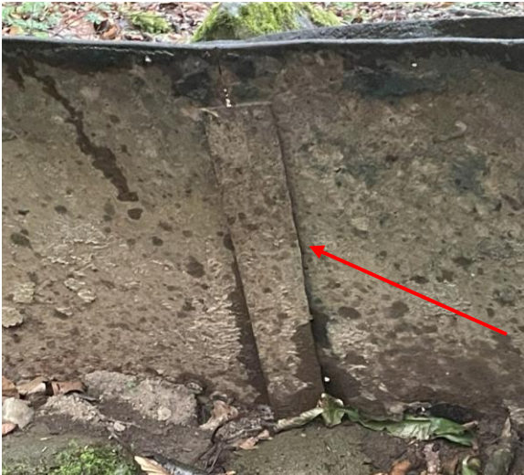
Vue intérieure de la solution de réparation.
