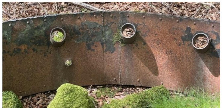
Ci-dessous, un élément de cuve intermédiaire (Ø int. 2,05m)
