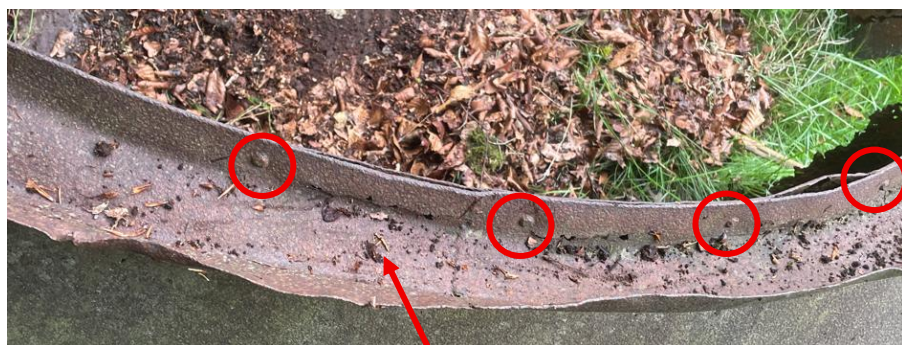
Gouttière d'interface évasée lisse rivetée.
