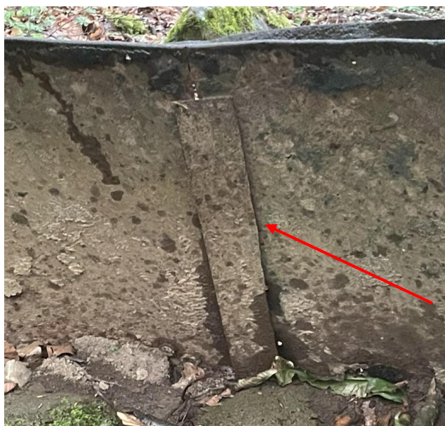
Vue intérieure de la solution de réparation.
