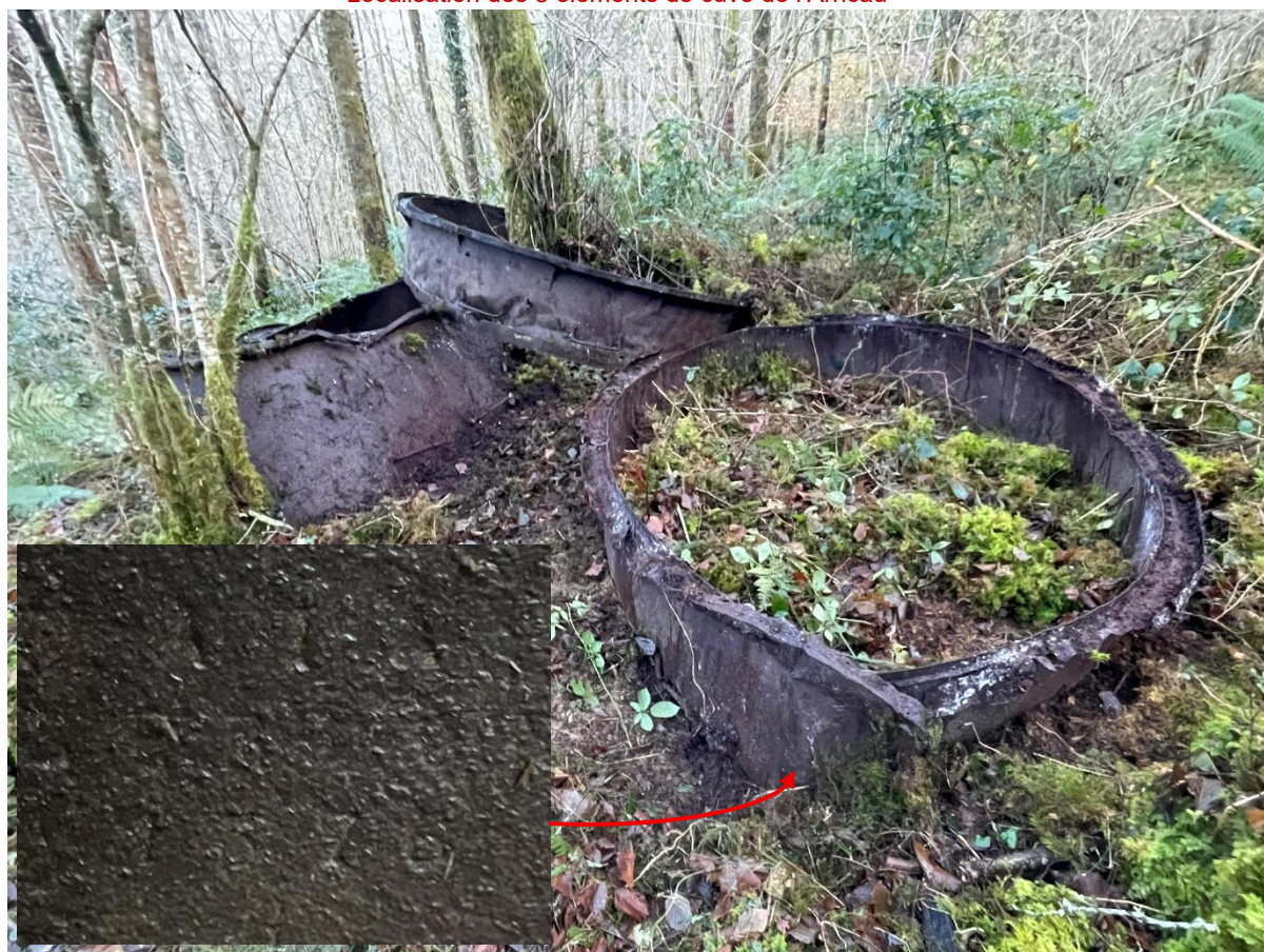
Les 3 éléments de cuve de l'Arricaü et dont celui de l'AIA Clermont N° 1376
